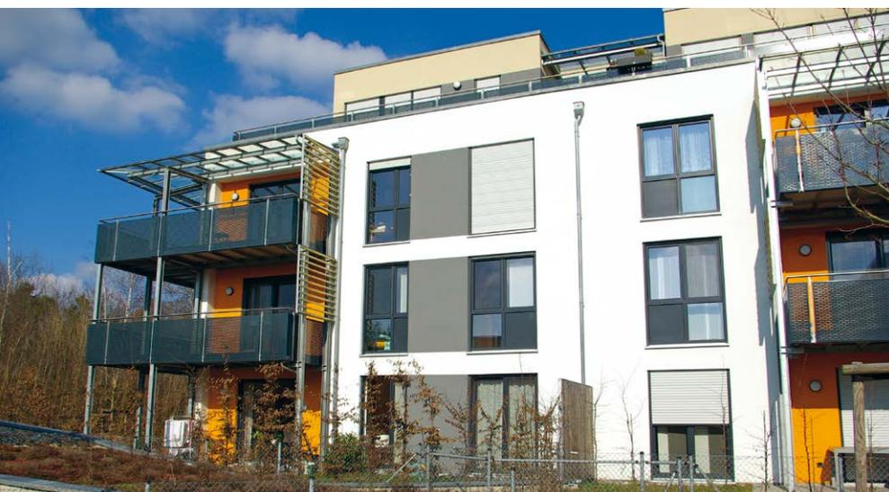
Moderne Außenwand mit Wärmedämmverbundsystem
