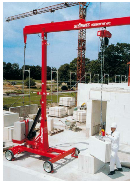
Durch den Einsatz von mobilen Versetzgeräten („Mini-Kränen“) können auch Ein-Mann-Teams KS-QUADRO verarbeiten.
