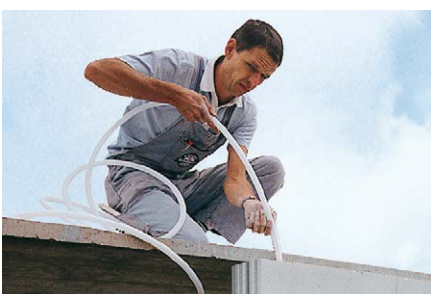
Verteilung der Installation am Wandkopf.
