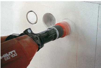
Kernbohrung für die Dosensetzung.
