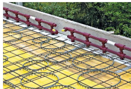
Deckenaufbau mit Schalung.
