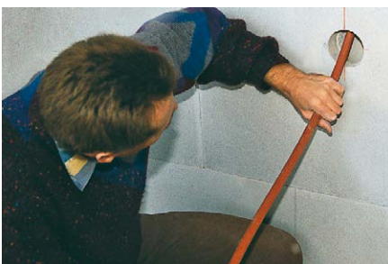
Einfädeln der Leerrohre oder Kabel.
