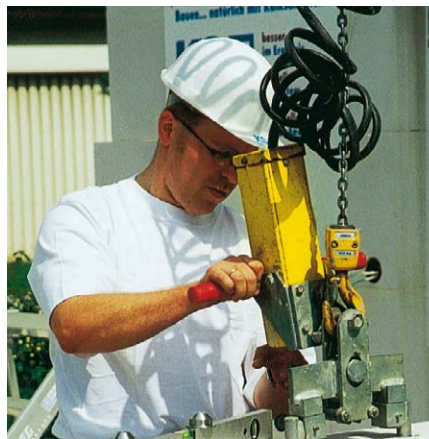
KS-QUADRO Minikran mit KS-Bügelgreifer.
