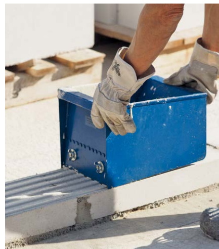
Mörtelauftrag mittels Schlitten.
