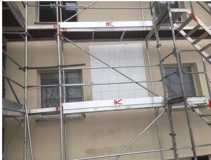
Rückbau einer Fassadendämmung im Schienensystem
