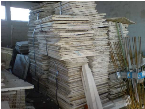
Rückbau einer Dachdämmung
