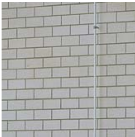
Bild 8: Kleinformatisches, glattes KS-Sichtmauerwerk, Format 2 DF
