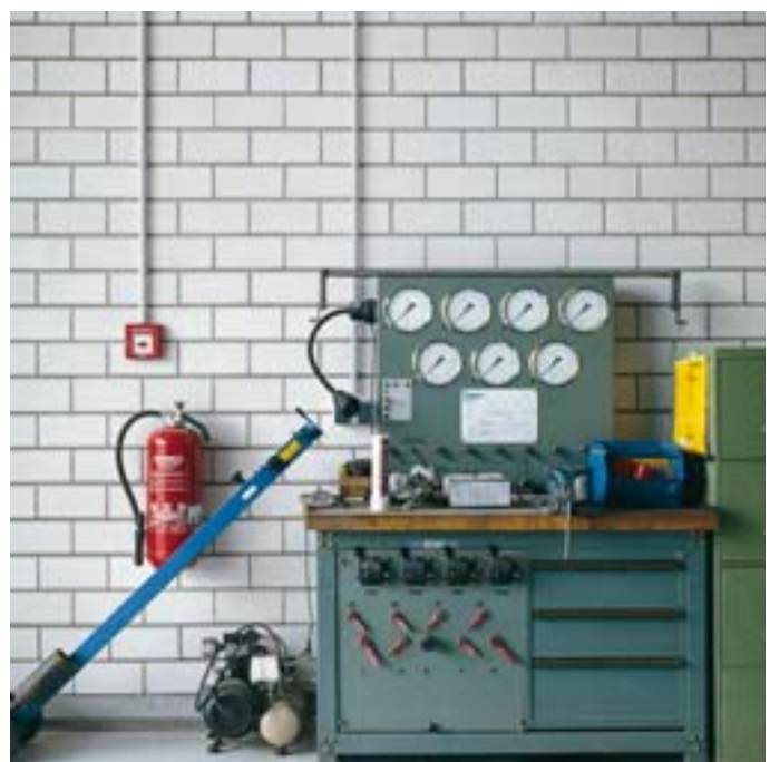
Hydrophobiertes KS-Sichtmauerwerk sorgt bei Verschmutzung für leichte Reinigung.
