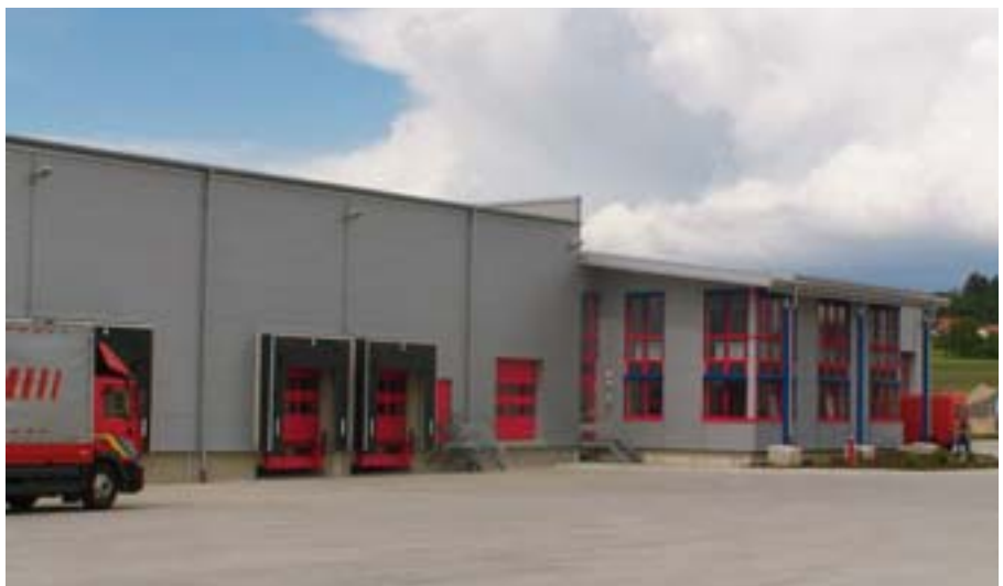
Güterumschlaghalle mit angrenzendem Verwaltungsgebäude
