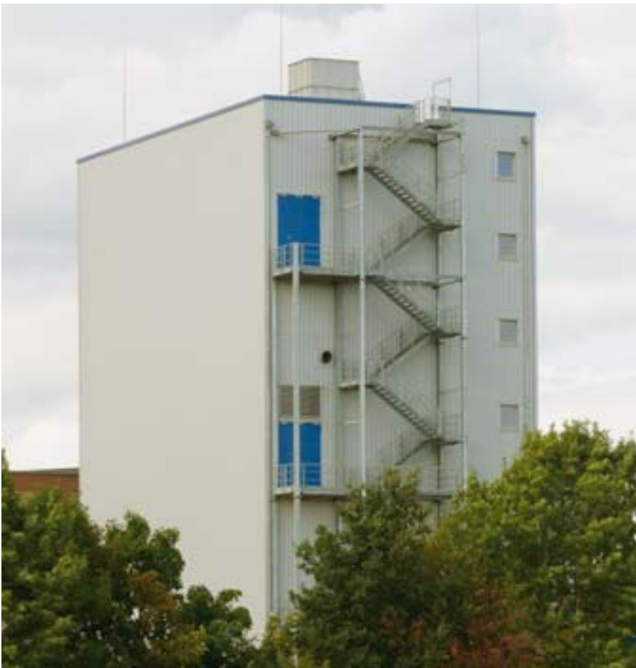
Die Konstruktion des Turms orientiert sich an den technischen Erfordernissen der Sprühtrocknung.
