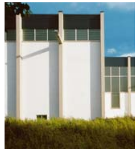
Bild 7: Produktionsgebäude mit nicht tragenden Außenwänden aus Kalksandstein.
