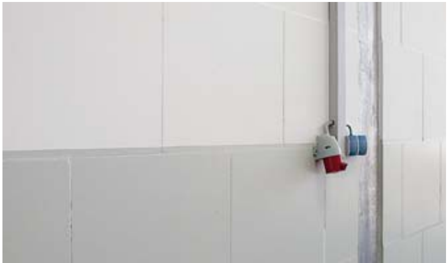
Deckend gestrichenes KS-Plansteinmauerwerk
