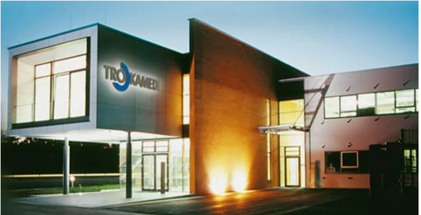
Die orangefarbene Brandwand trennt Verwaltung (links) und Produktion (rechts).
