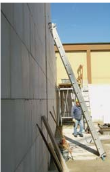
Beim Sprühturm kamen KS XL-Rasterelemente zum Einsatz.
