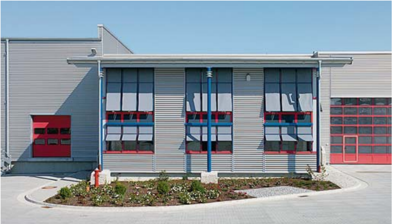
Silbern gestrichene Wellblechprofile verbinden die unterschiedlichen Gebäude.
