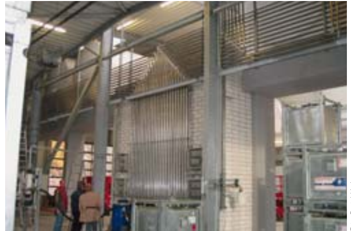
Lager und Abfüllhalle der Brachthäuser GmbH Co. KG (2004), 57413 Finnentrop Entwurf: Bertold Luke, BDB, 57413 Finnentrop, www.architekt-bertold-luke.de
