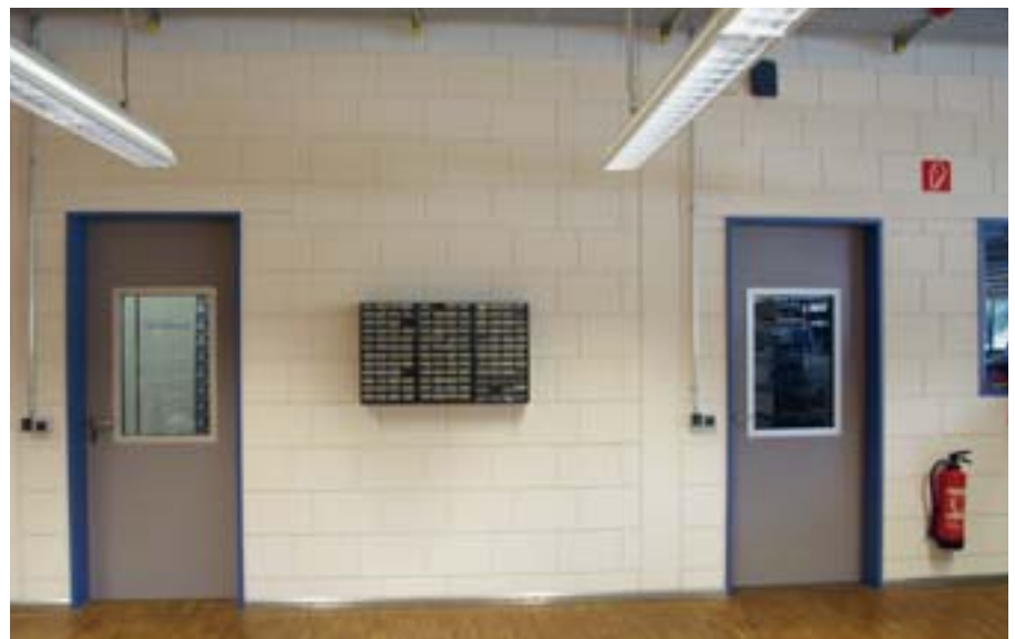
Das Stahlbetonskelett ist mit KS-Fasensteinen ausfachung.
