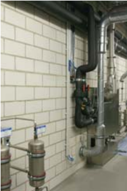
Leitungsführung und KS-Mauerwerk wurden sichtbar belassen.
