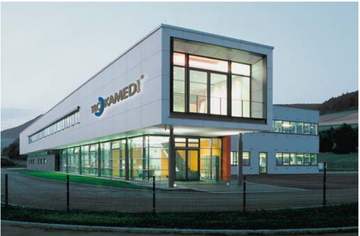
Das Obergeschoss hat eine Länge von 79 m.
