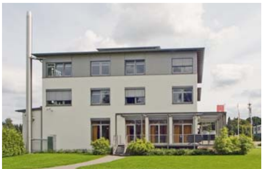
Bild 7: Bürogebäude mit Lochfassade
