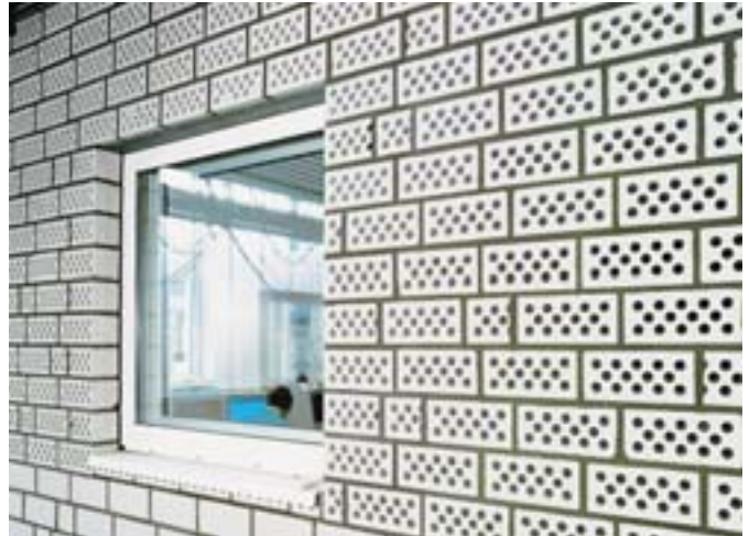
Bild 7: Schallschluckwand aus KS-Lochsteinen mit werkseitig durchstoßener Lochung
