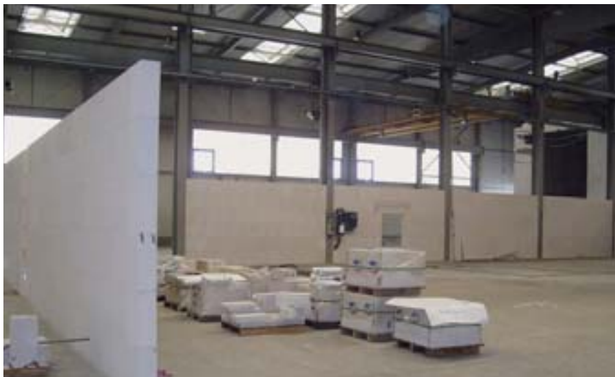
Bild 4: Nicht tragende Innenwände aus Kalksandstein unterteilen eine Halle in kleinere Einheiten.
