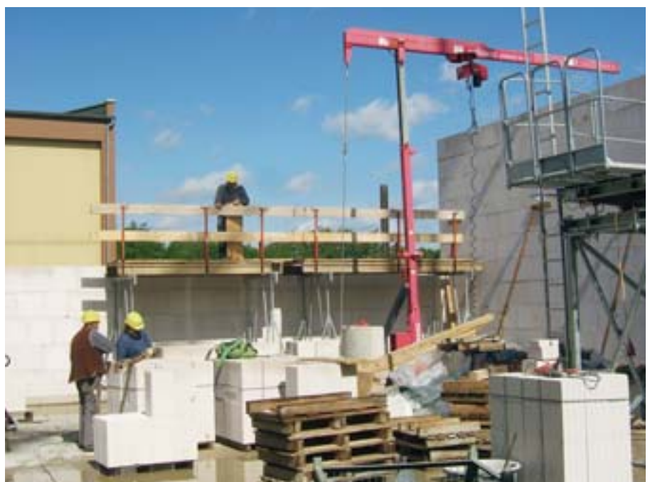
Durch die Wandscheiben konnte die Windaussteifung des Turms kostengünstig realisiert werden. Aufwändige Rahmenkonstruktionen konnten entfallen.
