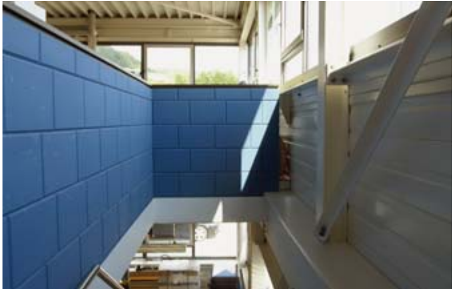
Deckend gestrichene KS-Fasensteine setzen Akzente.
