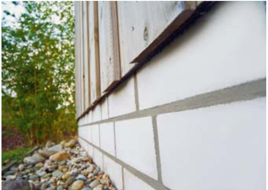
Fußpunktausbildung mit Kiesstreifen
