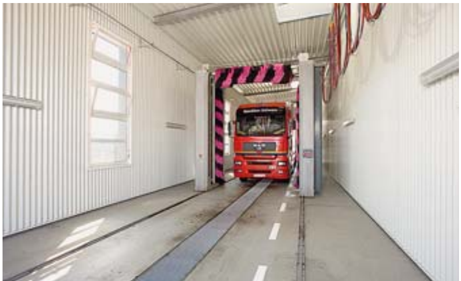
Waschkammer mit stehender Stahlblechverkleidung
