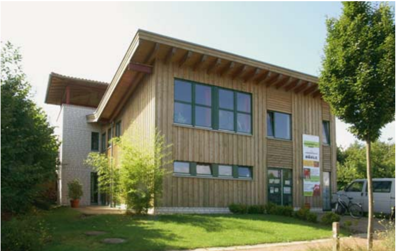
Zweigeschossiges Ateliergebäude in massiver Kalksandstein-Bauweise
