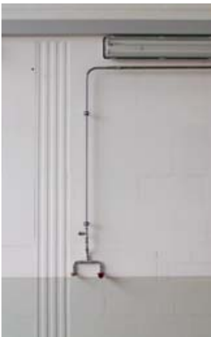
Das Nut-Feder-System der durchstoßenden Wand sowie Installationen bleiben sichtbar.
