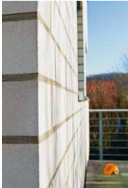
KS-Verblendmauerwerk des Turms
