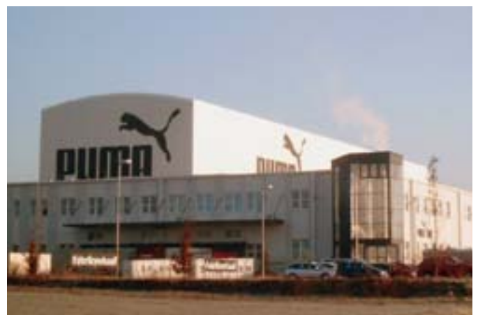
Logistikzentrum PUMA AG (1996), 96132 Schlüsselfeld Entwurf: Architekturbüro Benno Heer, 90427 Nürnberg
