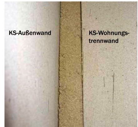
Abb. 7: Stumpfstoß zwischen Außenwand und Wohnungstrennwand mit beidseitig gelöster Mörtelfuge [25]
