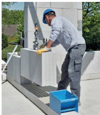
Bild 20 Versetzen von KS XL in Dünnbettmörtel
