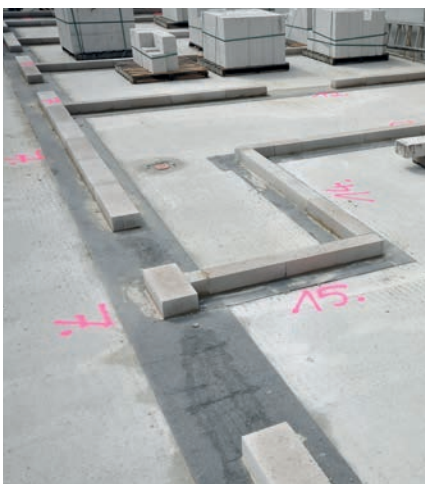
Bild 19 Anlegen der Kimmerschicht
