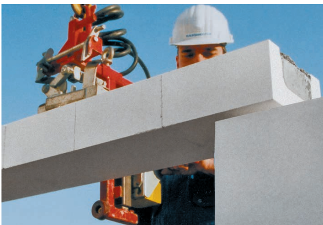
Bild 24 Vorgefertigte KS-Flachstürze zur schnellen und rationellen Öffnungsüberdeckung
