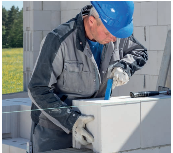
Bild 18 KS-R-Plansteine für Dünnbettmörtel
