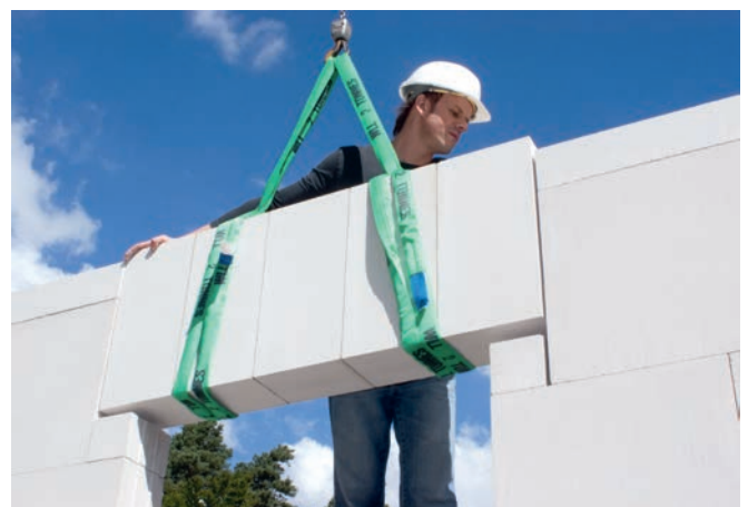
Bild 25 KS-Fertigteilstürze für großformatiges Mauerwerk
