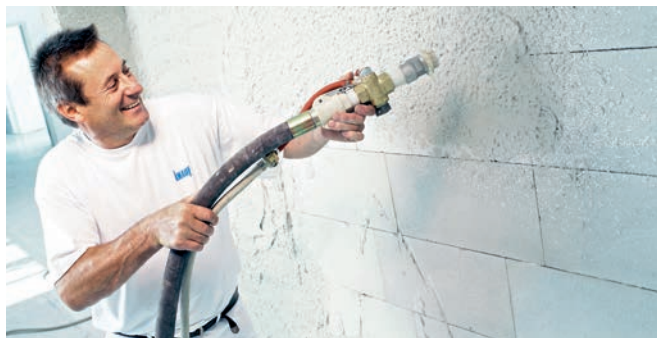
Bild 9 Arbeitsschritte beim Verputzen einer Wand; Maschineller Auftrag des Putzmörtels
