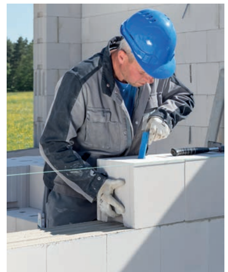
Bild 4 Versetzen von KS-R-Plansteinen in Dünnbettmörtel
