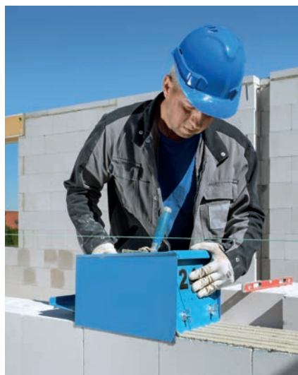
Bild 3 Dünnbettmörtelauftrag mit Mörtelschlitten
