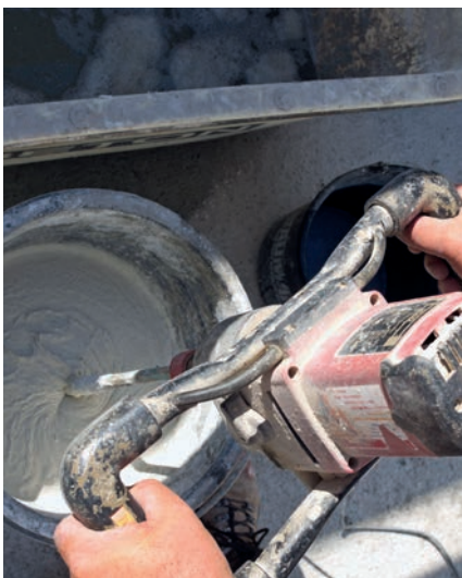
Bild 2 Anmischen von Dünnbettmörtel
