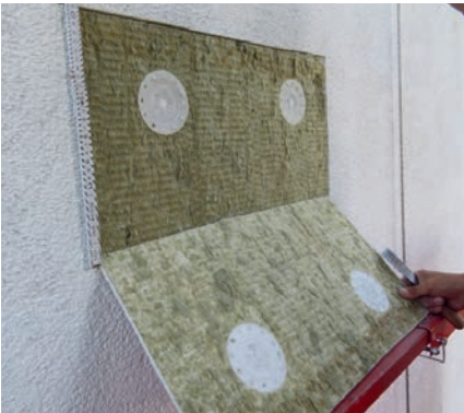
Bild 24 Oberflächenbündig eingebauter Dämmstoffdübel
