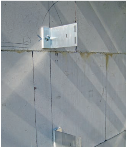
Bild 35 Vorgehängte hinterlüftete Fassaden mit Aluminium-Unterkonstruktion
