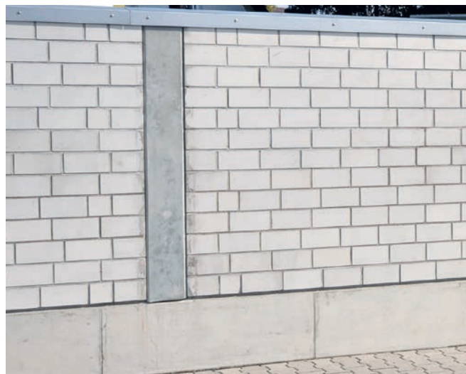
Bild 43 Freistehende KS-Wand mit horizontalen und vertikalen Aussteifungen
