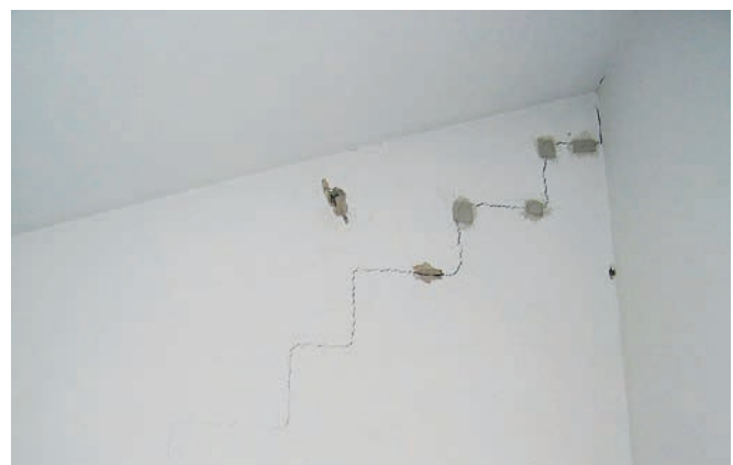
Bild 13 Rissbildung durch Verkürzung eines Stahlbetongurts
