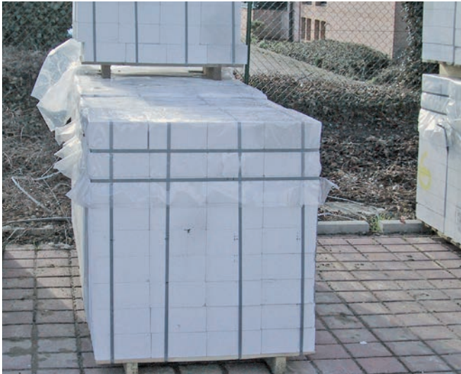
Bild 19 Lagern von Steinen mit Schutz gegen Niederschlag
