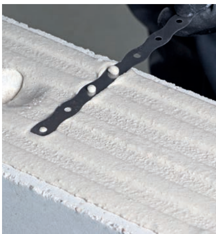
Bild 33 Stumpfstoßtechnik: Mörtelbett mit Edelstahl-Flachanker
