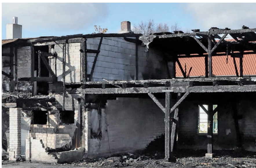
Bild 11 Durch einen Brand verkohlte Holzkonstruktion vor einer unversehrten Kalksandsteinwand; wegen ungetrennten Dachanschlüssen wurde das Feuer weitergeleitet
