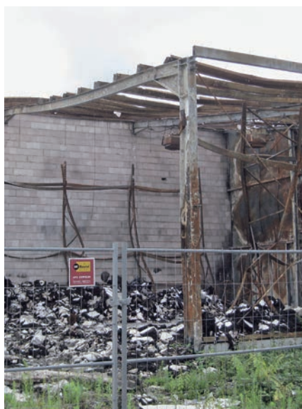
Bild 10 Durch Brand verformte Stahlkonstruktion vor unversehrter Kalksandsteinwand
