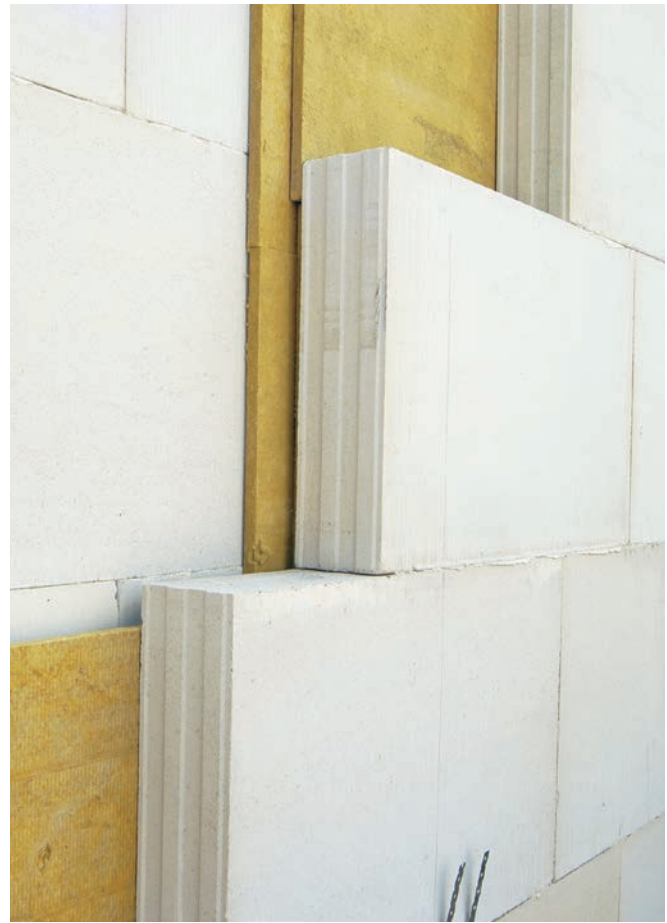
Bild 35 Dicht gestoßene Mineralfaserplatten Typ WTH vermeiden Schallbrücken
