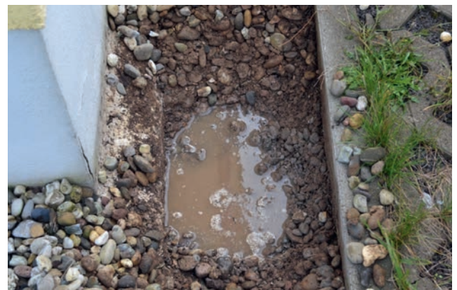
Bild 24 Kiesstreifen, in dem sich Wasser ansammelt und so an Sockeln zur Erhöhung anstelle zur Verringerung der Beanspruchung führt
