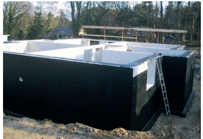
Bild 34 Kellerwand-Außenseite mit PMBC-Abdichtung
