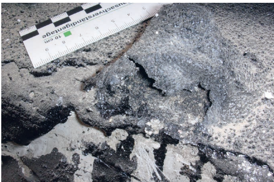
Bild 32 Aus Zuverlässigkeitsüberlegungen sollten auch bei der geringen Wassereinwirkung E1 Abdichtungen an Beton von Bodenplatten hinterlaufsicher angeschlossen werden und nicht, wie hier im Bild, auf einen nicht vorbehandelten Untergrund aufgetragen werden. Damit kann bei eventuell später auftretender, geringer Stauwasserbildung an den unteren Wandenden Wasserschäden im Gebäude verhindert werden
